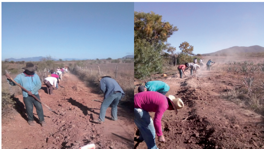
Figura 5. Construcción de línea de conducción de agua para riego, San Pedro Mártir Quiechapa.
