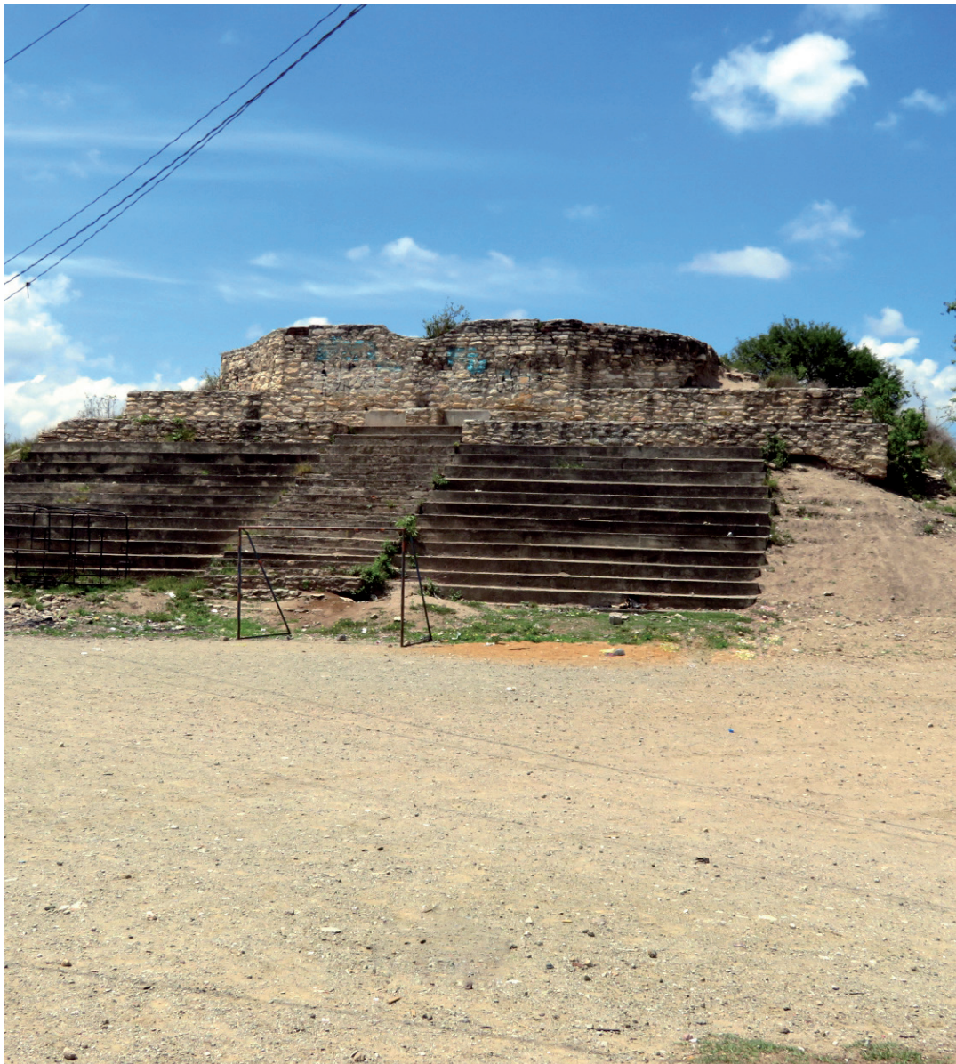
Lámina 19. El Guexe. La fachada norte del Montículo Sur con las gradas construidas en años recientes. Foto cortesía de Cira Martínez López, enero 2021.
