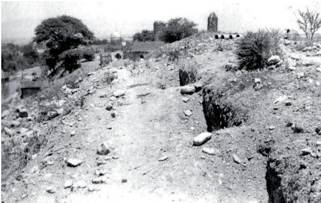
Lámina 15. El Guexe. La zanja para la tubería del agua en el lado oeste del sitio parcialmente tapada. Vista hacia el norte. Foto de WOA.
